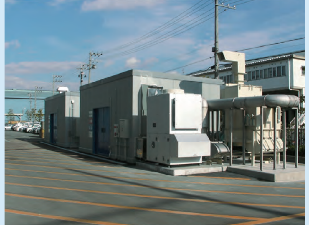
危険物屋内貯蔵所・危険物一般取扱所
