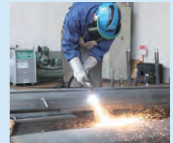
プラズマ切断機
