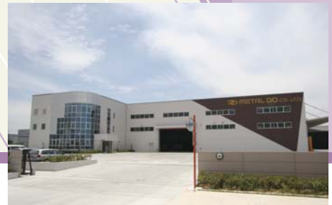
延べ床面積6,580㎡の新2nd 物流センター。屋根には144枚のソーラパネルを設置している。
